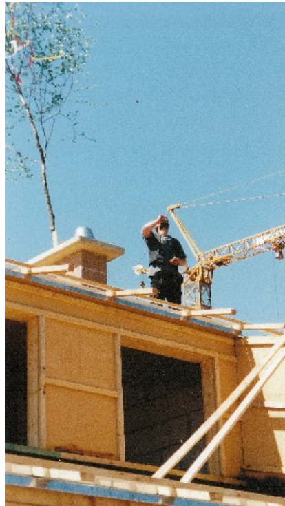
Richtfest auf Haus 6: Der Zimmermann stößt an
