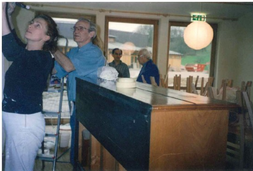
Fleißige Hände beim Innenausbau des Hauses 5 im Jahr 2000
