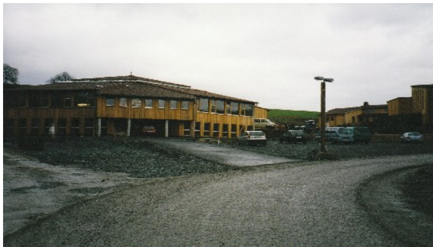
Die Werkstatt kurz nach der Fertigstellung im Jahr 2000
